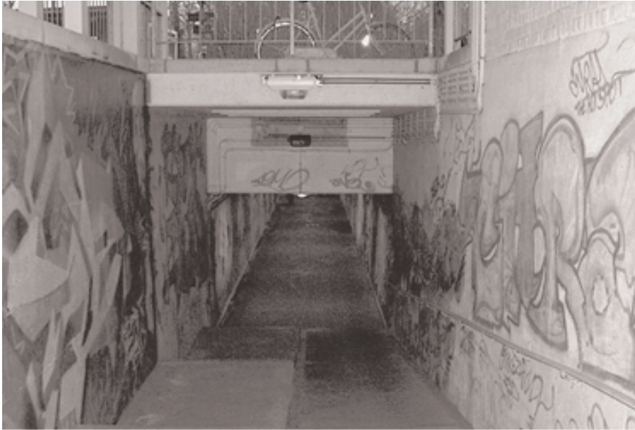
FOTO 1: TUNNEL ONDER RINGWEG
